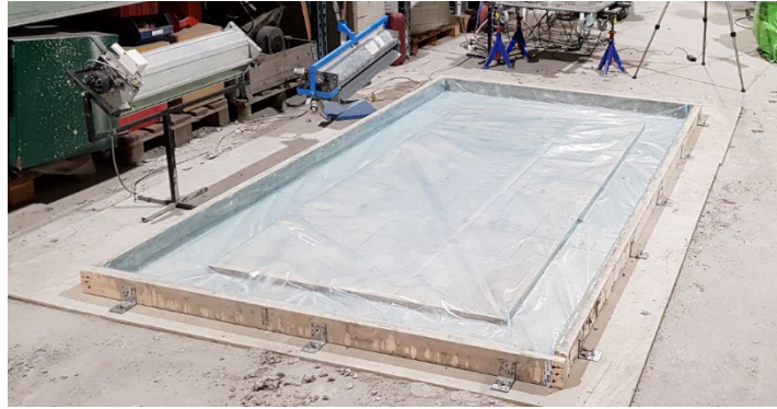
Figur 3.3 – Form före gjutning vid halvskaletförsök. Utrustning för parallella ringförsök skymtar i bakgrunden
